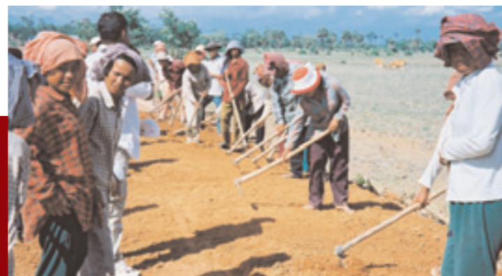
Mit vereinten Kräften: ländlicher Straßen- und Wegebau
